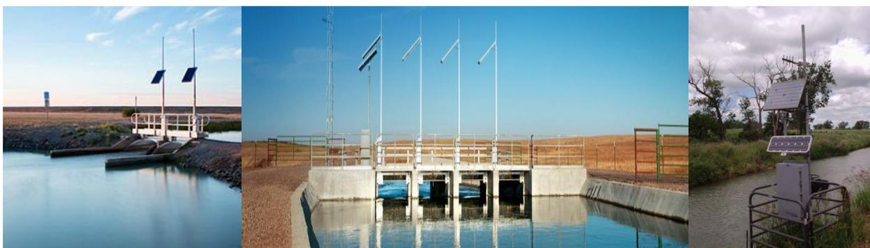
Рис. 1. Элементы технологической радиосети автоматизированной системы управления оросительными каналами: радиомачта с антенной, блок-бокс с электронным оборудованием и аккумуляторами, солнечные батареи. (Фото: [www.rubiconwater.com](http://www.rubiconwater.com), [www.campbellsci.com/south-dakota-irrigation](http://www.campbellsci.com/south-dakota-irrigation))
