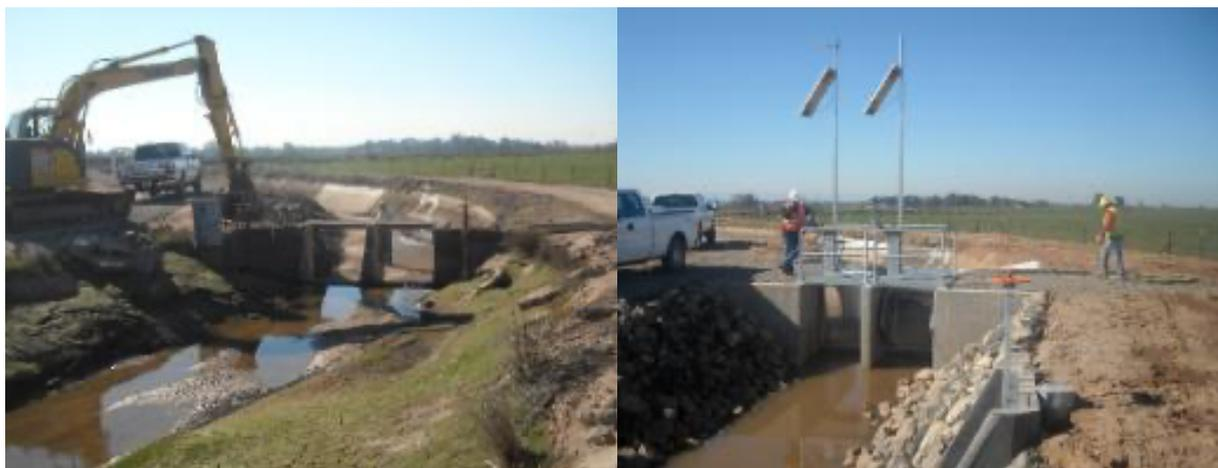
Рис. 3. Ворота шлюзов до и после модернизации системы орошения и внедрения АСУ.
